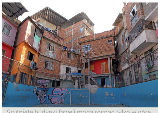
Ścisnięte budynki faweli mogą rosnąć tylko w górę.
